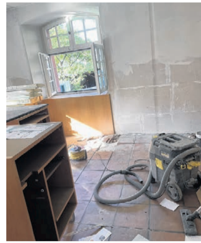
Zurzeit sind die Umbauarbeiten an der Baselstrasse 31 in vollem Gang. Anfang Juli wird die Chrischona-Apotheke dort wieder eröffnet und in neuem Glanz erscheinen.
